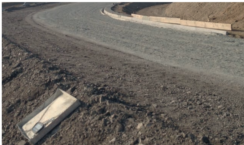
Spandimento del legante e verifica del dosaggio
