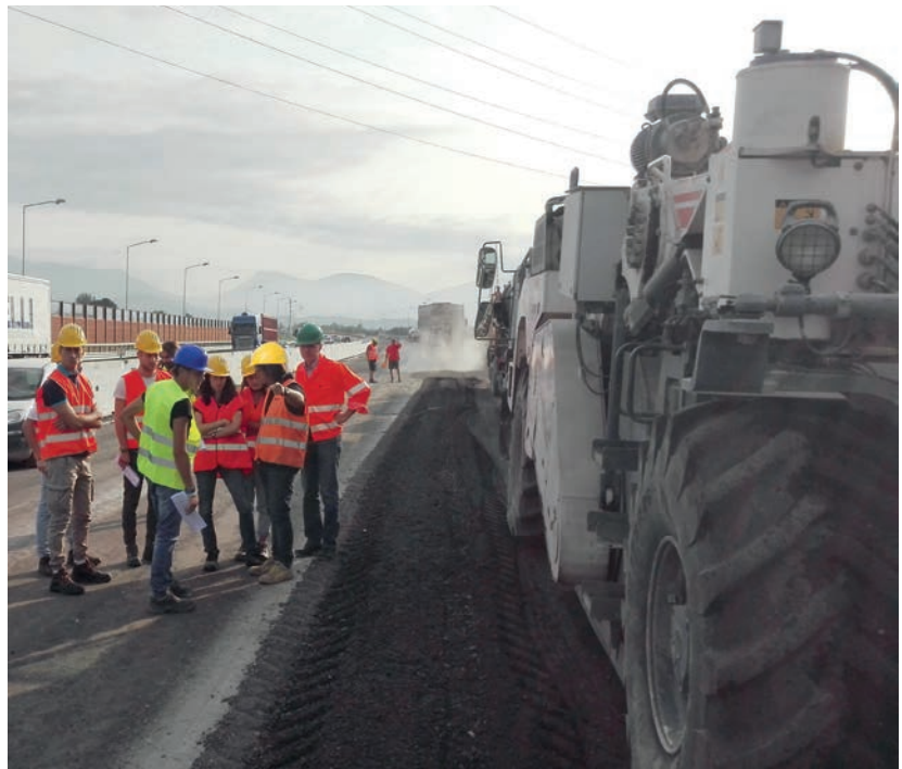
Treno di riciclaggio: autobotte con emulsione e stabilizzatrice WR
